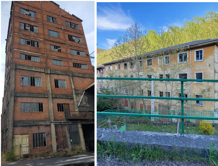
Edificios abandonados en Tremor.
